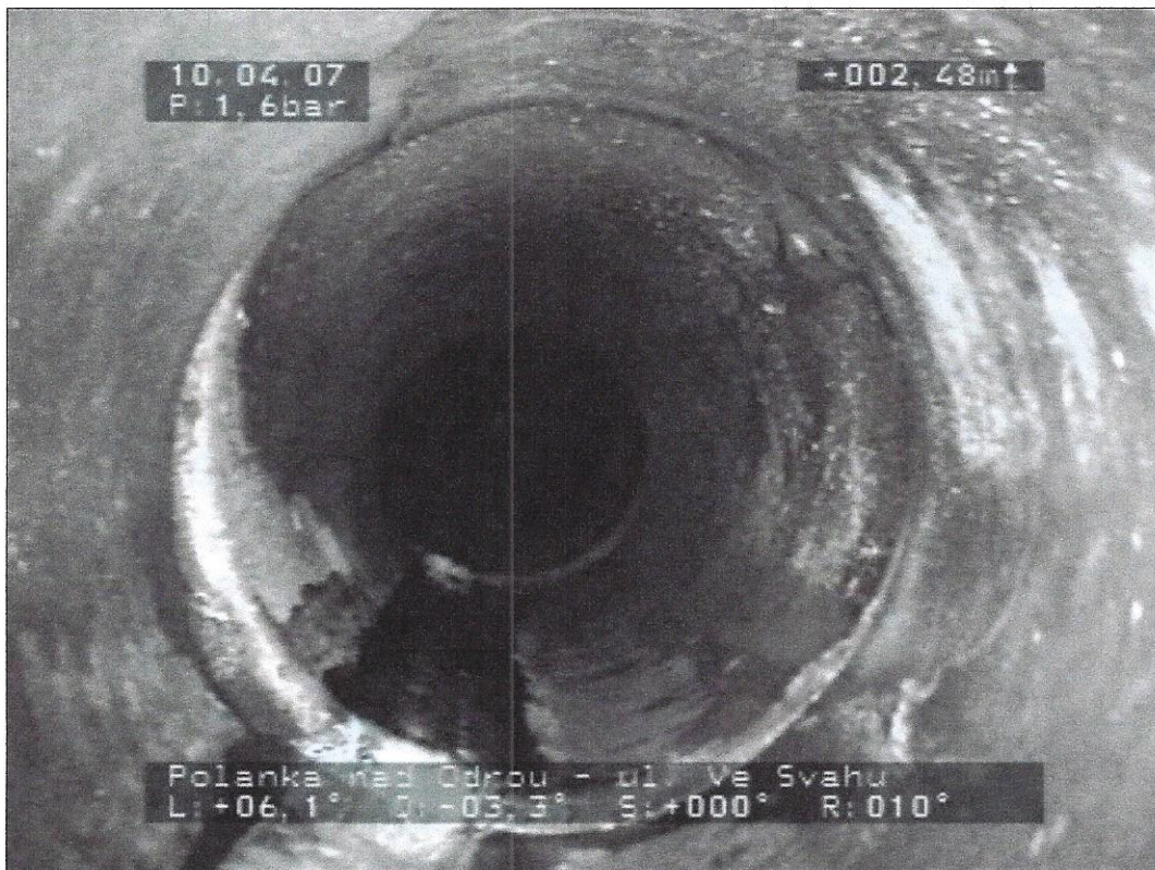
Stávající potrubí v ulici Ve Svahu
