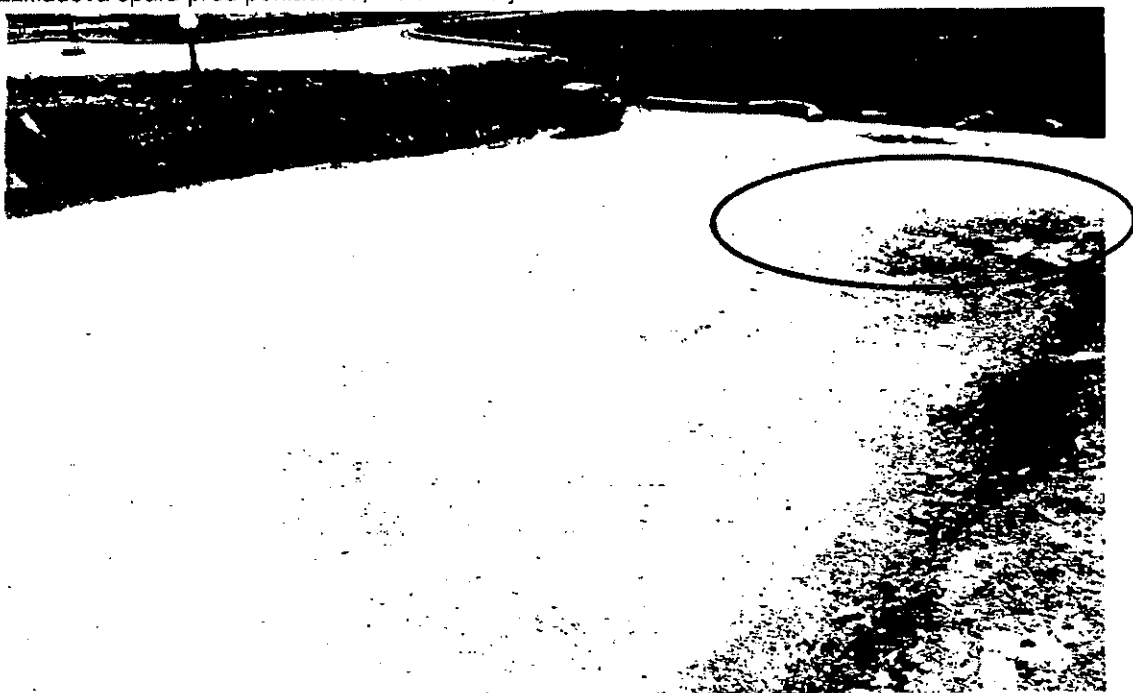
základová spára před pokládkou, viditelná stojící voda
