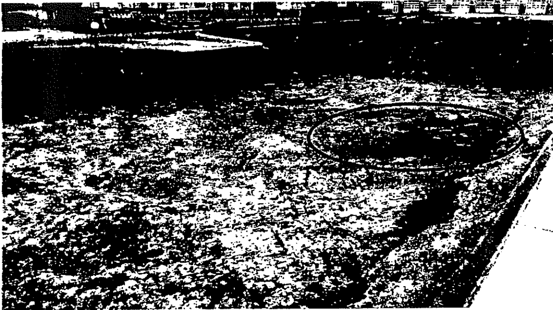
základová spára před pokládkou, viditelná stojící voda
