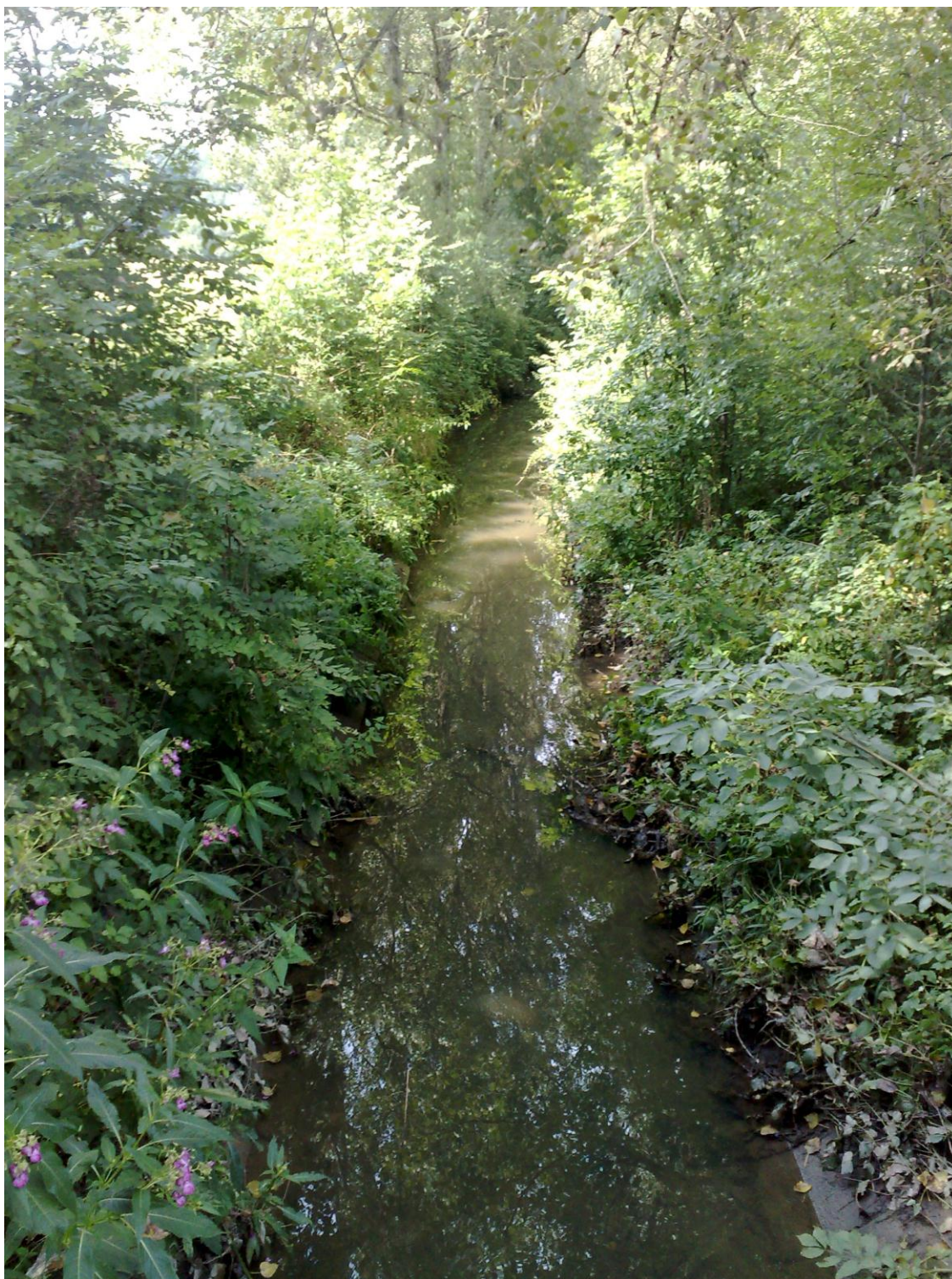
Upravené koryto Starobělského potoka
