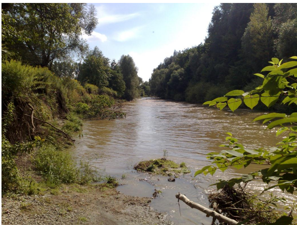
Pravostranná břehová nátrž v korytě řeky Odry
