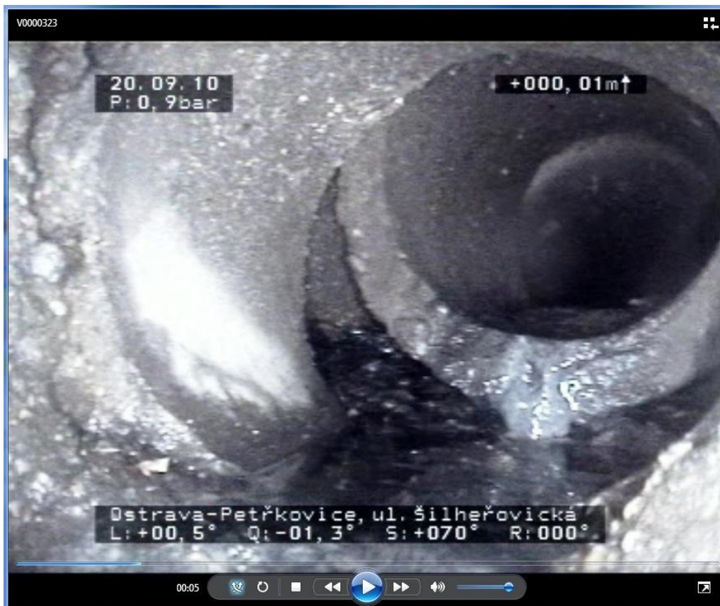
Napojení přípojky na potrubí
