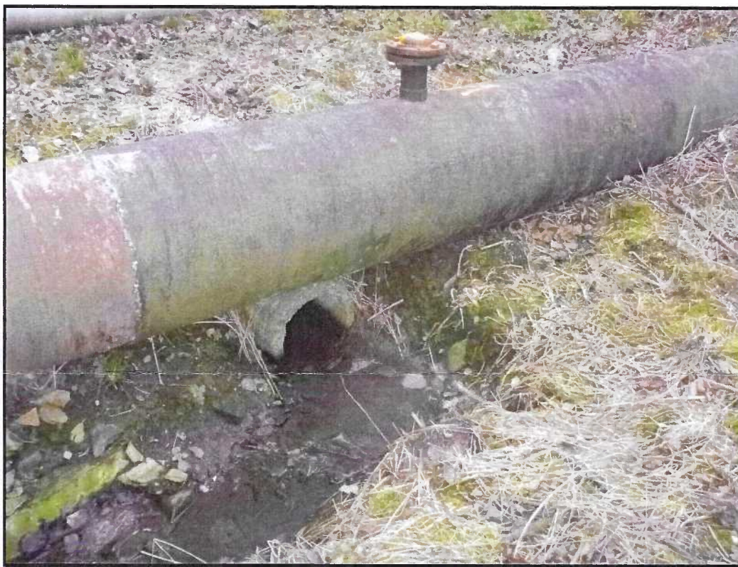
Výpust v ulici Na Liščině
