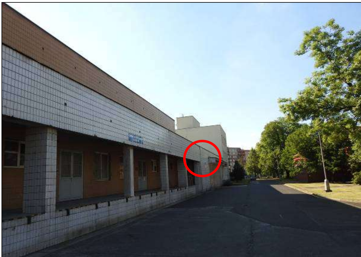
Obr. č. 2 – Červený polygon vymezuje místo kam rorýsi k větracím otvorům v průběhu června nejvíce nalétávali (9. 6. 2017).
