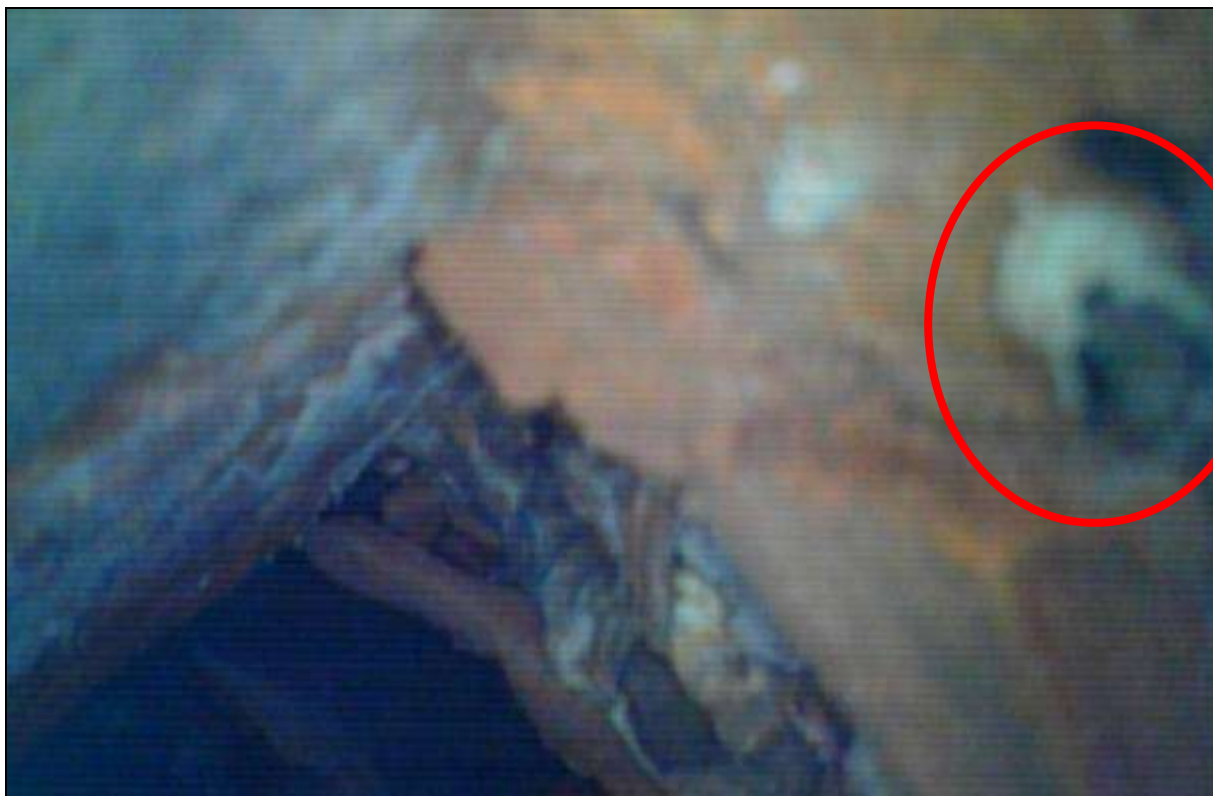
Obr. č. 4 – Červený polygon označuje trus rorýsů nalezený ve ventilačním otvoru na bílé budově. Záznam pochází z teleskopické inspekční kamery DeWalt DCT410, která má rozlišení VGA. Pořizování fotografií kamerou není vždy snadné, proto je fotografie natočená (11.8.2017).
