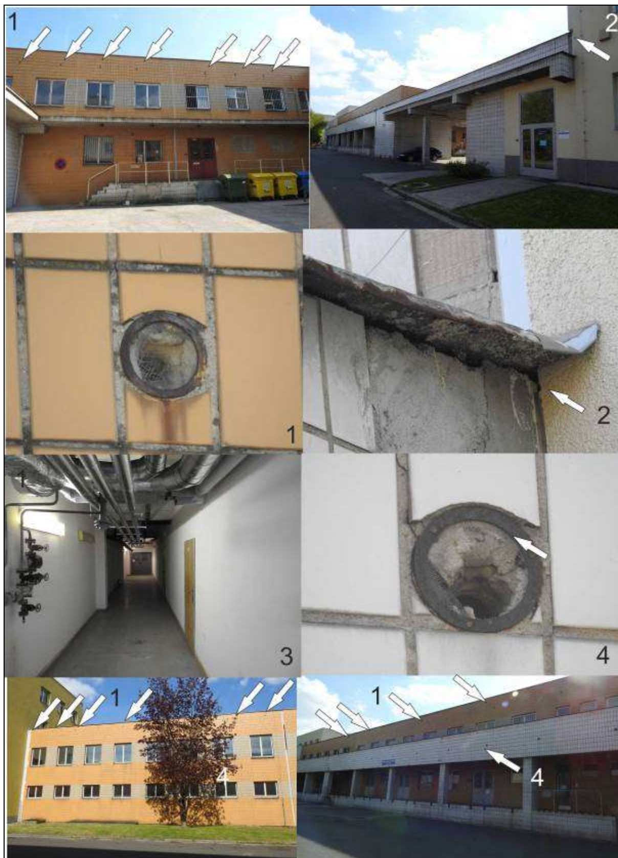
Obr. č. 1 – Budova CS/ sklad oddělení zásobování, pozice 1- větrací otvory v atice se na žluté budově nacházejí velmi hojně, bylo zde napočítáno 50 otvorů, z nichž téměř všechny mají narušenou či odpadlou mřížku, většina tak velmi dobře může sloužit jako úkryt a hnízdiště pro netopýry a ptáky; 2 - detail škvíry pod oplechováním střechy v místě dilatační spáry na budově hospodářské budovy a centrálního skladu; 3- přízemní prostory jsou vyhřívány ústředním topením a celoročně využívány, pro netopýry tedy velmi nevhodné a nevyužitelné prostory; 4- Na bílé budově se v atice nachází 12 otvorů, které rovněž mohou sloužit jako vhodné prostory pro ptáky a netopýry (24. 4. 217).
